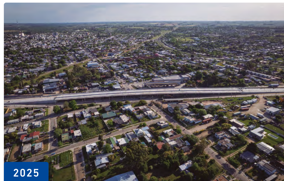
Renovación y ampliación de la Ruta Nacional n.º 5
