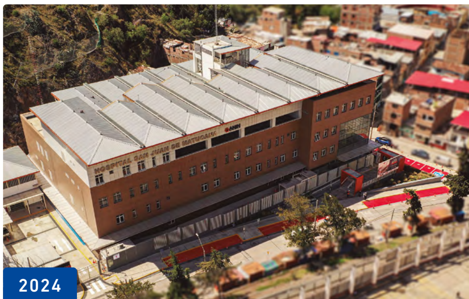
Ejecución de la obra en Perú Hospital San Juan de Matucana
